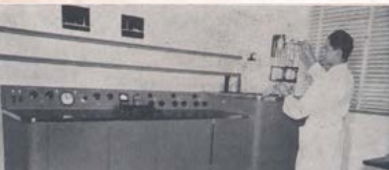
17. Ultracentrífuga múltiple Spinoe instalada en el departamento de Virus Neurotrópicos. Este aparato tiene un rotor que gira en una cámara refrigeradora de alto vacío a una velocidad de 60.000 revoluciones por minuto para producir fuerza centrífuga extraordinaria las cuales se utilizan para separar los virus y las moléculas de importancia biológica. Con este equipo se están realizando investigaciones sobre ciertas lipoproteínas de la sangre que intervienen en los procesos de arteriosclerosis cerebral, con contribución a la lucha contra una de las más graves afecciones generales del sistema nervioso.
